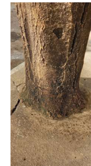
Impermeabilização do solo e do colo do tronco com cimento
