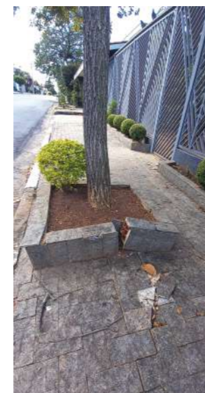
Plantar árvore acima do nível do solo com uma saia de alvenaria. Notar que a planta levantou o passeio.
